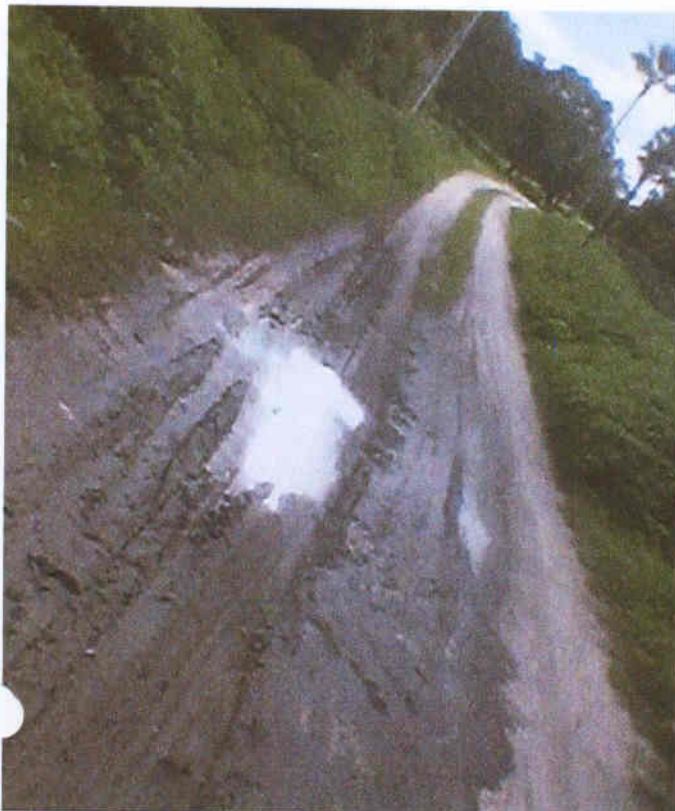
ROTA 77 - TRECHO VEREDA DOS JULIOS, FAZENDA MOAGEM, CAJAZEIRAS, SALGADO DOS ARRUDAS
