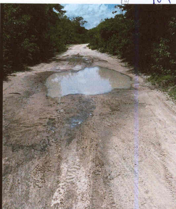
ROTA 77 - TRECHO VEREDA DOS JULIOS, FAZENDA MOAGEM, CAJAZEIRAS, SALGADO DOS ARRUDAS
