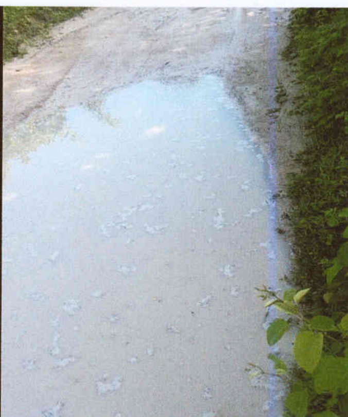
ROTA 74 e 78 - TRECHO BOQUEIRÃO, SANTA HELENA - ESCOLA NAPOLEÃO FONTENELE
