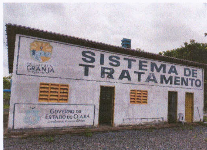
Figura 20 – Casa de operação da elevatória
