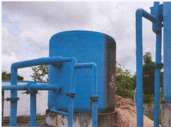
Figura 17 – Filtro Descendente com material colmatado que foi retirado ao lado
