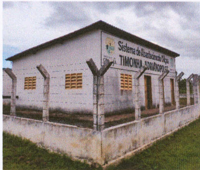
Figura 6 – Fachada da ETA
