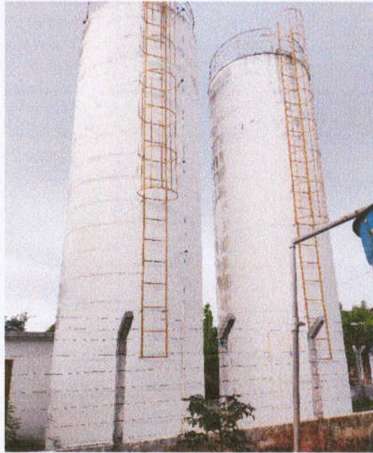
Figura 13 – Reservatórios apoiados de Adrianópolis
