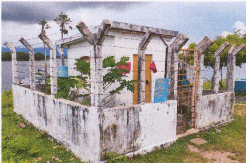
Figura 4 – Casa do quadro na captação
