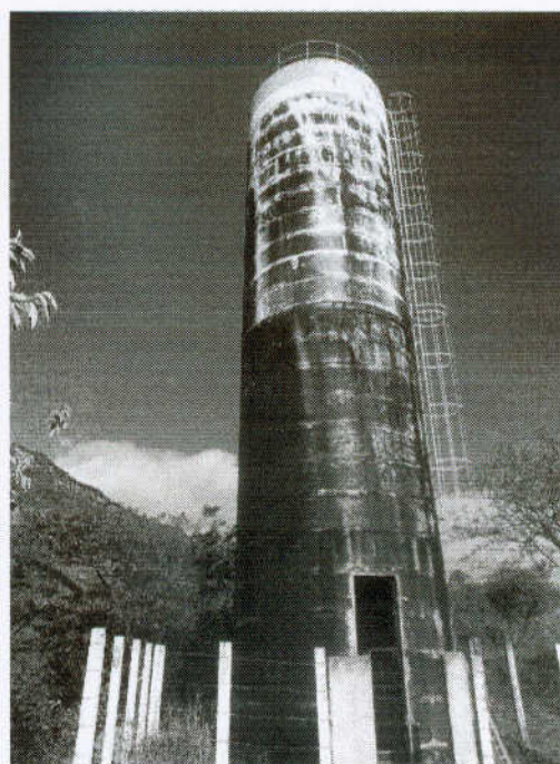
Vista Geral do Reservatório (Brejo)
