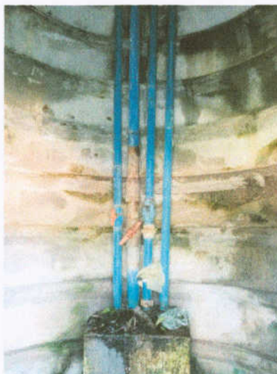
Figura 03 – Vista interna das tubulações abaixo do fuste do Reservatório do Córrego da Raiz
