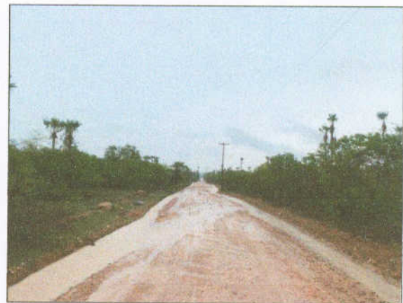
Foto 16 – trecho em revestimento primário, com interferências (rede elétrica na margem da via).
