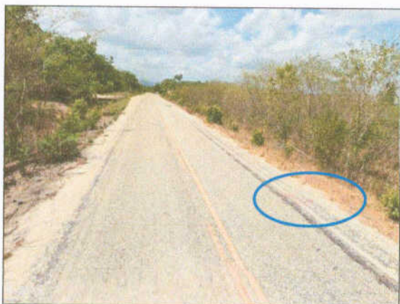
Foto 11 – Rodovia CE-311 local de implantação da estaca 00.
