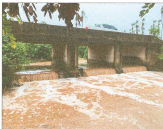
Foto 04 – estaca 1.564+15,00 vista lateral de bueiro BTCC.
