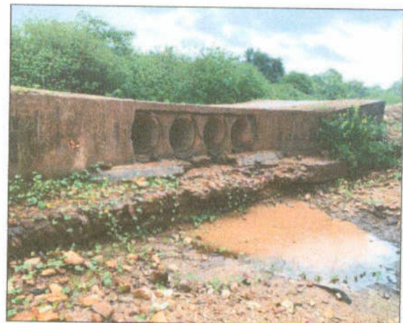
Foto 10 – vista lateral da passagem molhada
