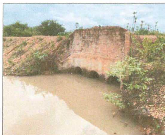
Foto 06 – boca de bueiro BTTC sem alas com muro elevado de alvenaria de
