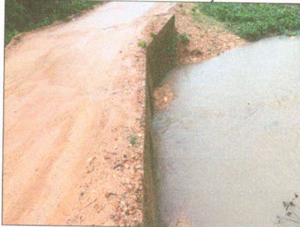
Foto 09 – vista superior da passagem molhada
