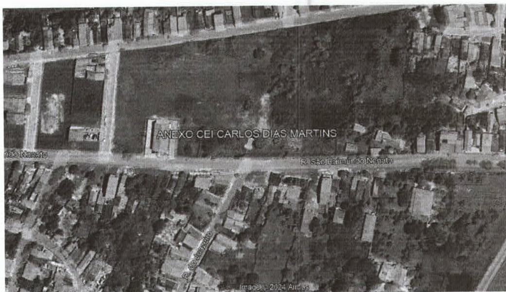
Figura 22: Telhado do ANEXO CEI CARLOS DIAS MARTINS
