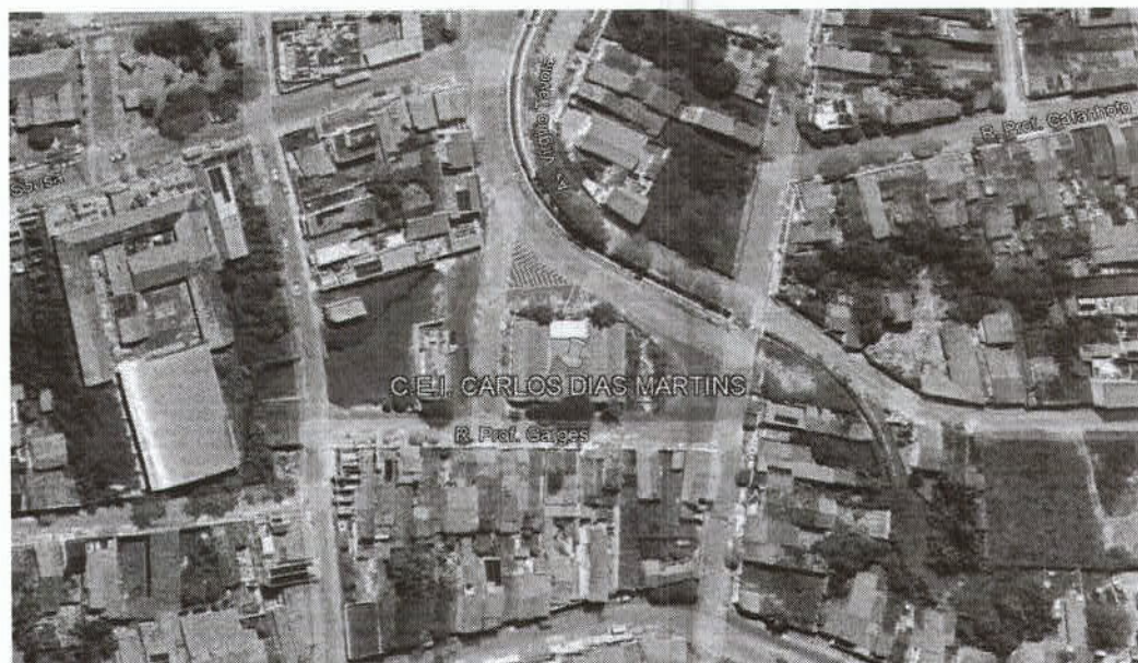
Figura 13: Telhado da C.E.I. CARLOS DIAS MARTINS
