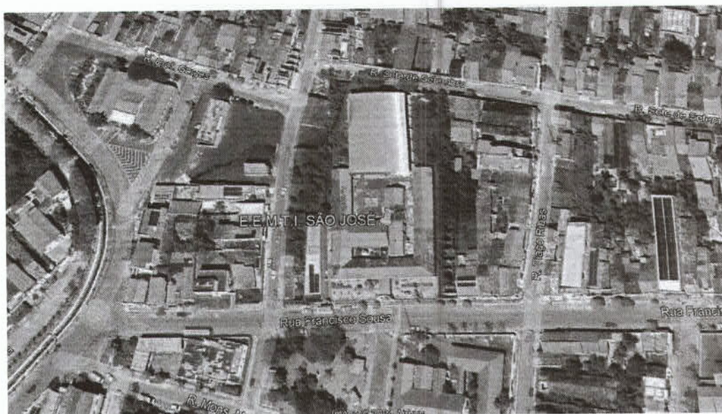
Figura 15: Telhado da E.E.M.T.I. SÃO JOSÉ
