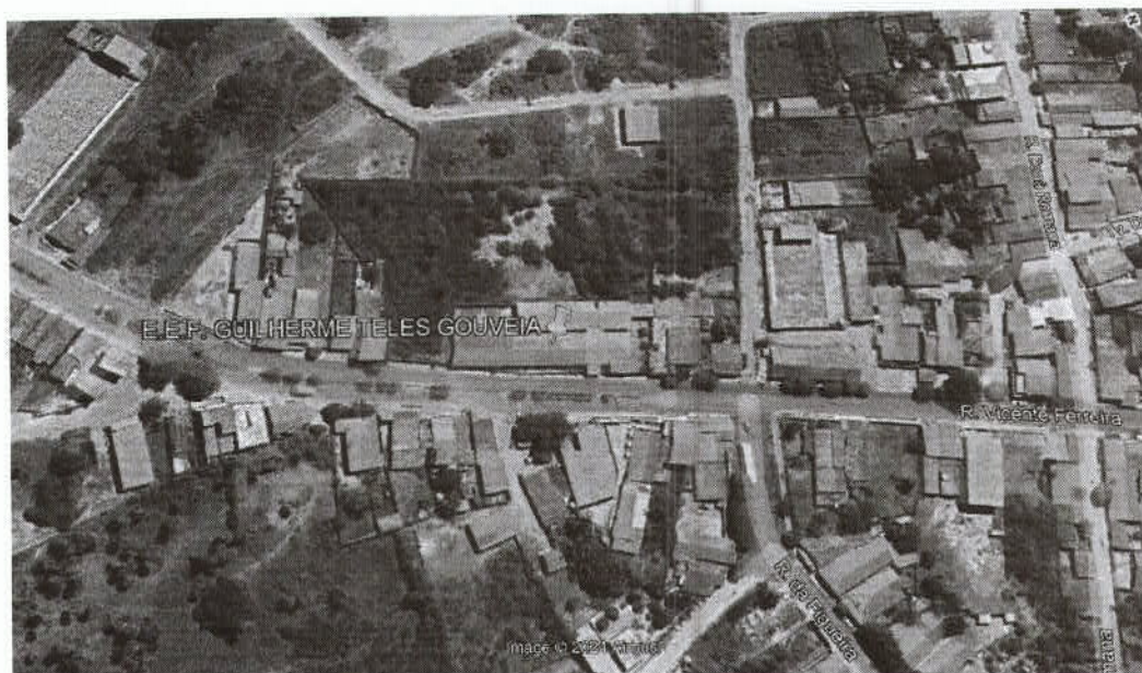
Figura 5: Telhado da E.E.F. GUILHERME TELES GOUVEIA
