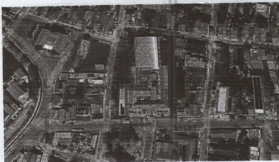
Figura 15: Telhado da E.E.M.T.I. SÃO JOSÉ
