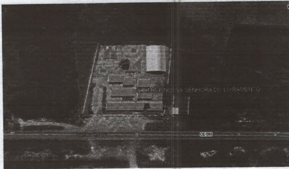
Figura 21: Telhado da E.E.M.T.I. NOSSA SENHORA DO LIVRAMENTO
