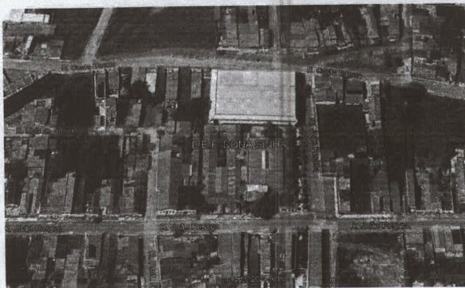
Figura 11: Telhado da E.E.F. DONA SINHÁ
